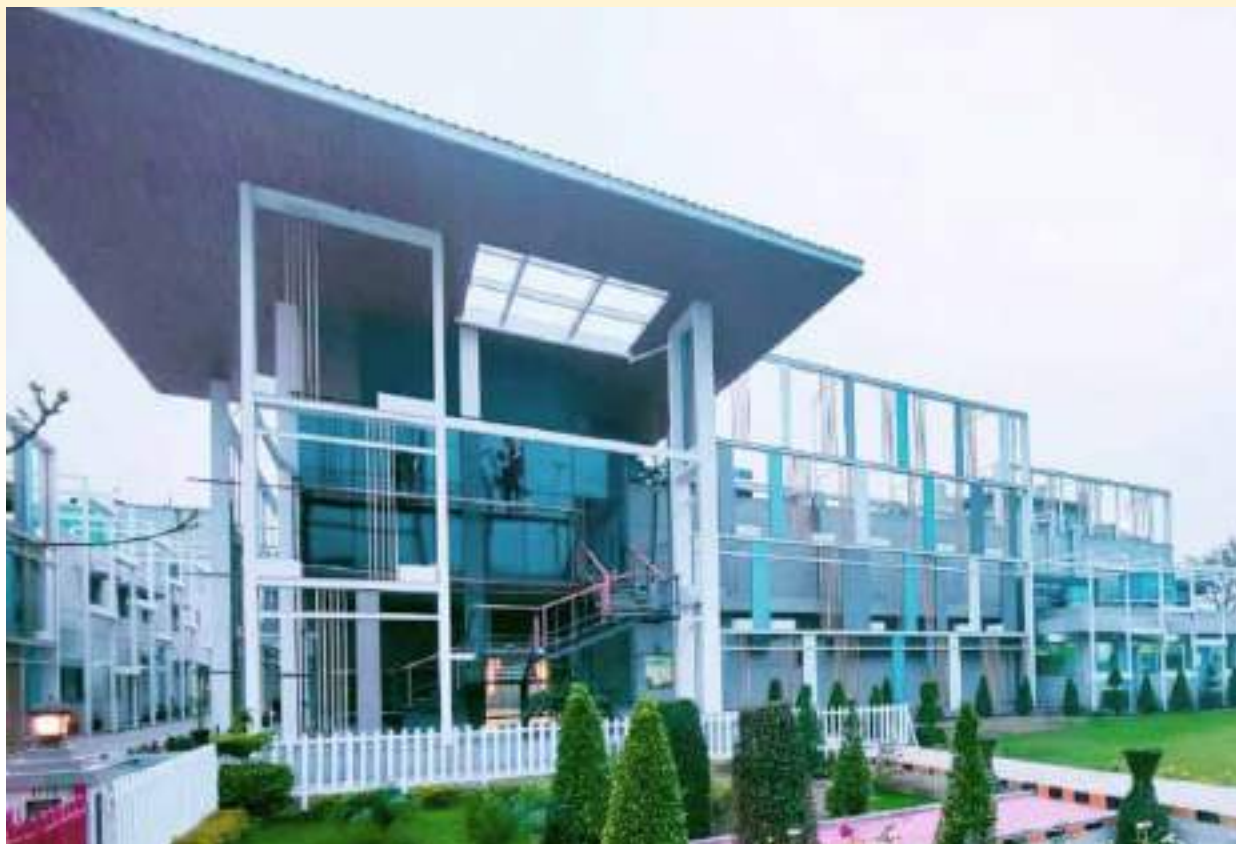
Searle I.V. Solutions Plant.
